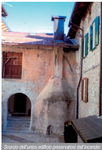
Scorcio dell'unico edificio preservatosi dall'incendio
