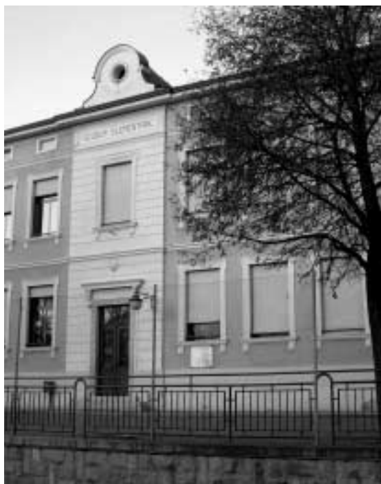
Edificio scolastico di Scurelle
