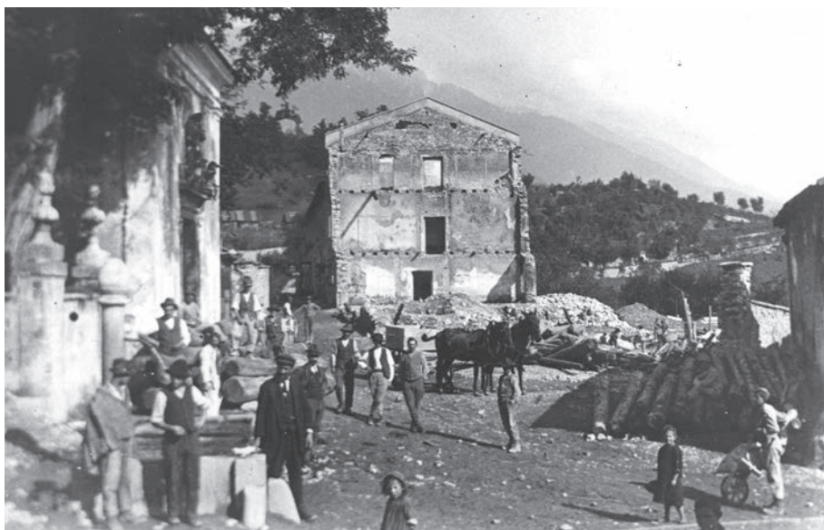
Novembre 1920: deposito di legname da costruzione in piazzetta San Giovanni, sullo sfondo dei ruderi di casa D'Anna. (Foto: archivio L. Girotto – fondo p. L. Ferrai )
