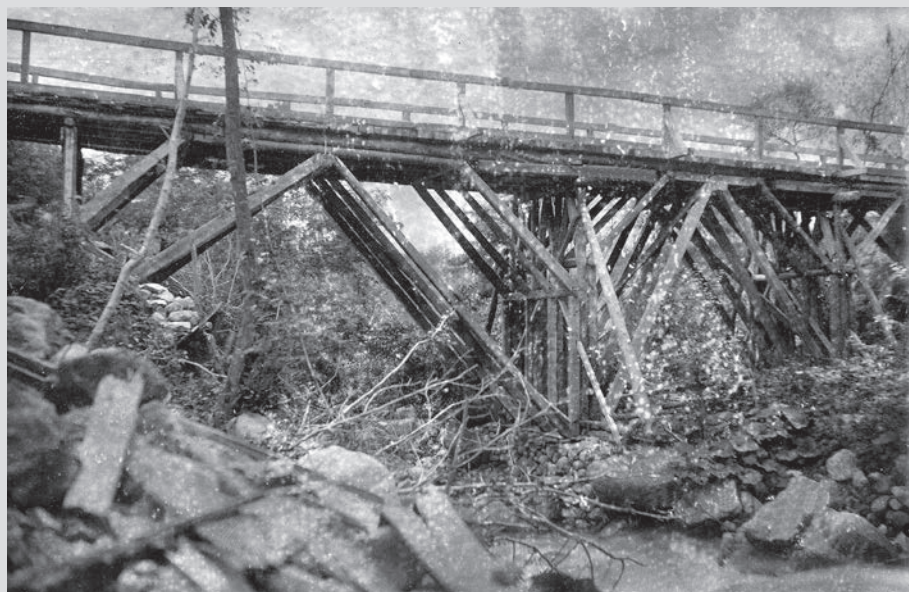
Visione ravvicinata della passerella costruita sul Ceggio da un plotone della VI Baukompanie aggregata alla 181ª brigata di fanteria austro-ungarica. (Foto: archivio G. Todesco )
