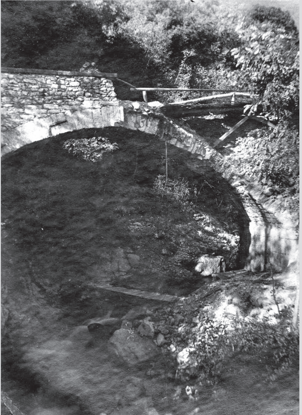
Il ponte sul Ceggio, tra Telve e Borgo, nell'estate del 1916; in bella evidenza i danni, provvisoriamente rimediati dai pionieri austriaci, causati dall'esplosione dei 75 kg di gelatina esplosiva durante la ritirata italiana da Borgo. (Foto: archivio G. Todesco )
