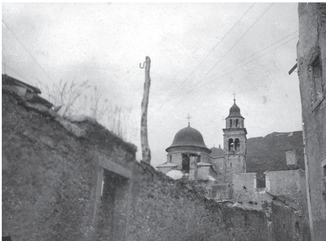
Da via S. Giustina sono evidenti i danni causati dall'artiglieria all'abside della chiesa di S. Maria Assunta. (Foto: archivio L. Girotto )
