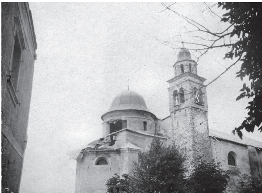
La chiesa parrocchiale di S. Maria Assunta, con la copertura dell'abside sfondata da una granata. (Foto: archivio L. Giroto )
