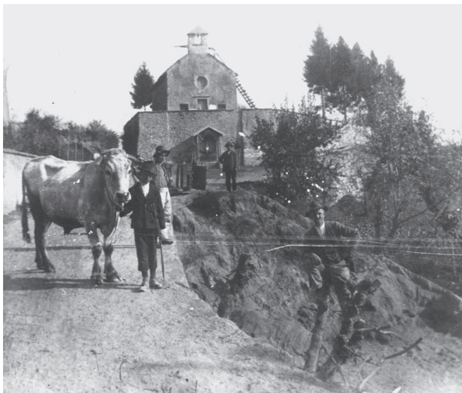
1921: lavori in corso in via S. Giustina ed alla cappella cimiteriale. (Foto: archivio L. Girotto - fondo p. L. Ferrai )
