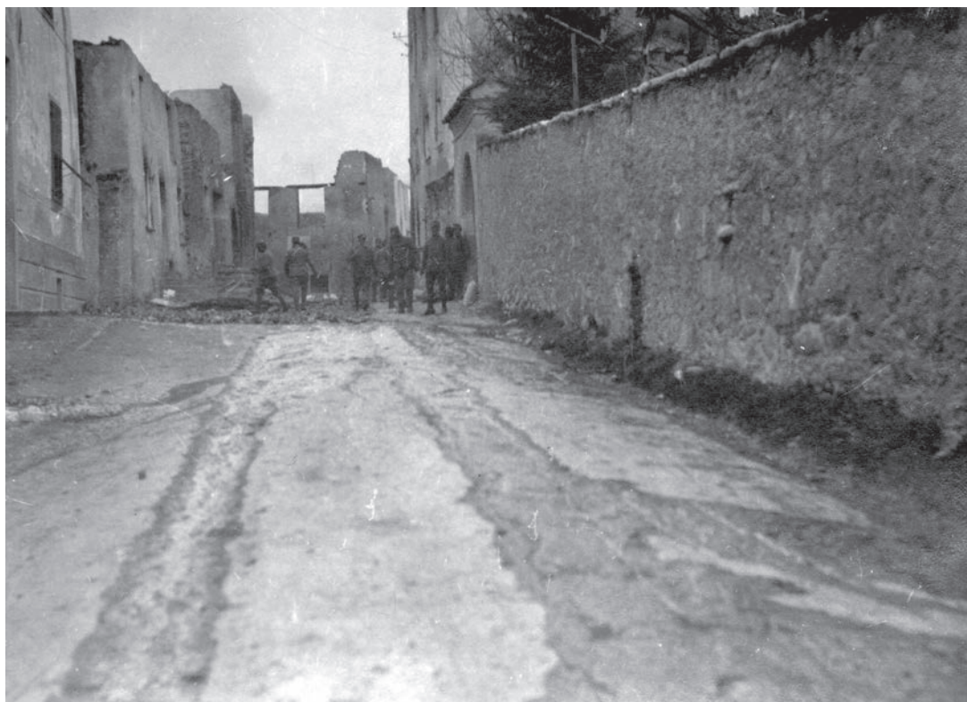
Via Canonica, fotografata da est verso ovest. Sulla destra il muro del cortile della canonica. (Foto: archivio L. Girotto )
