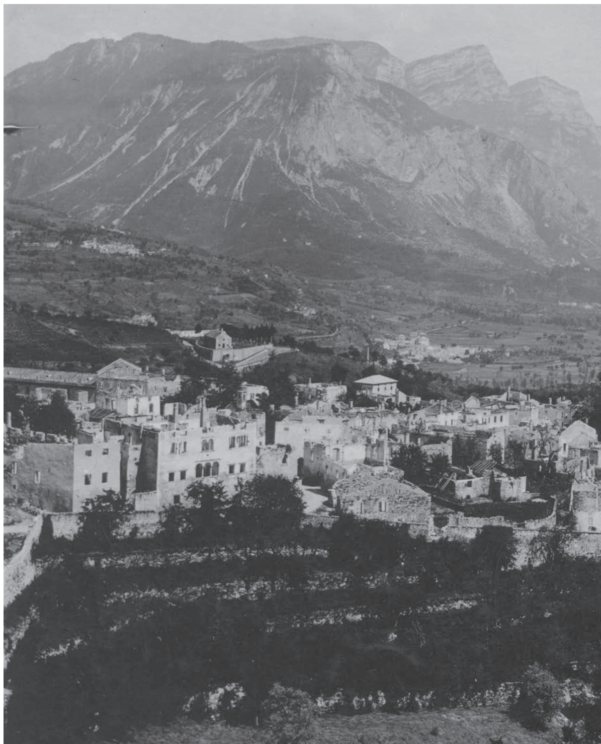
Visione panoramica di Telve, da Telve di sopra, nel giugno 1916. Solo pochissimi edifici hanno mantenuto la copertura, nonostante gli incendi ed i ripetuti bombardamenti. (Foto: archivio L. Girotto )
