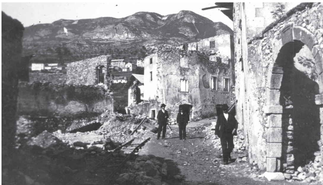
17 ottobre 1920: via alle Scuole e panoramica su largo Cacciatori, sul quale si affacciano le rovine dell'edificio che attualmente ospita il bar Birreria Baldi. (Foto: archivio L. Girotto – fondo p. L. Ferrai )
