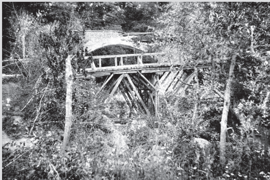
Il ponte sul Ceggio e la passerella lignea provvisoria allestita nel giugno 1916 per assicurare il transito ai carriaggi ed agli autocarri che salivano nottetempo a Telve. (Foto: archivio G. Todesco )
