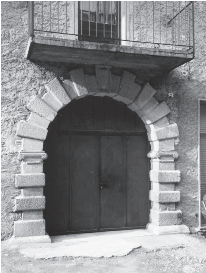
Portale casa Bertondello Via delle Filande (4/92). L'edificio rimaneggiato dai danni della Grande Guerra. Portale in pietra calcarea, unica testimonianza del palazzo della nobile famiglia strignata.
