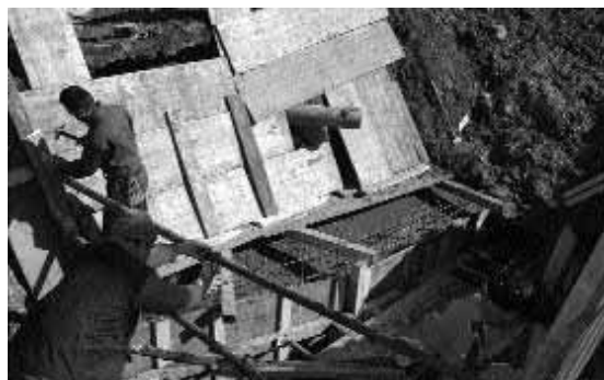
Lavori sulla rete fognaria - Imer
