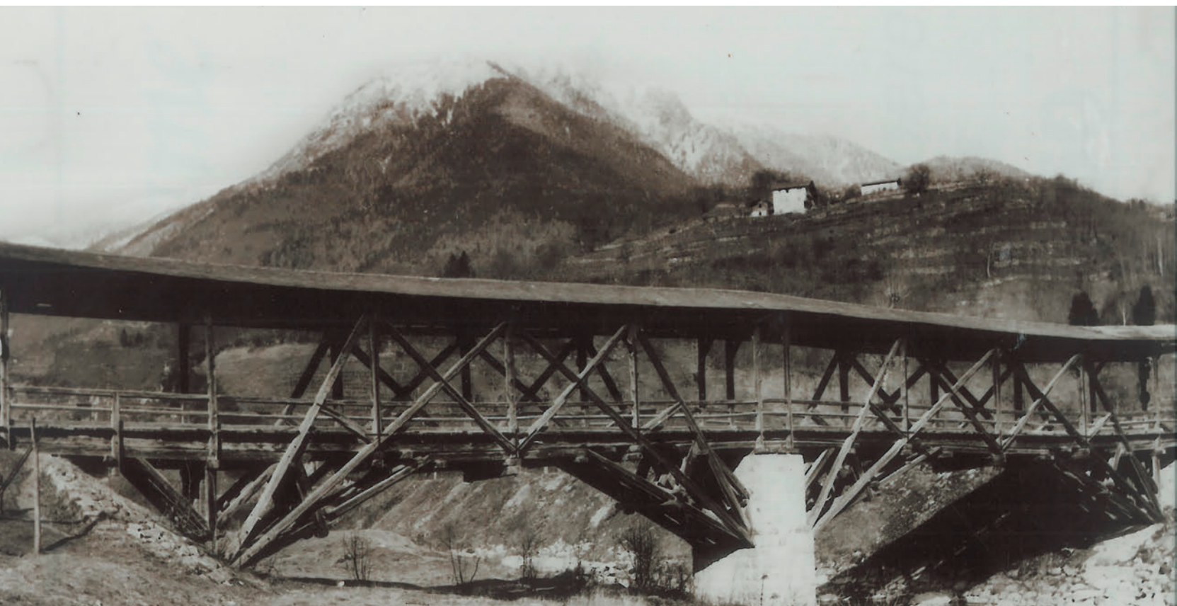
Ponte di Carzano. Anni '50-'60.
