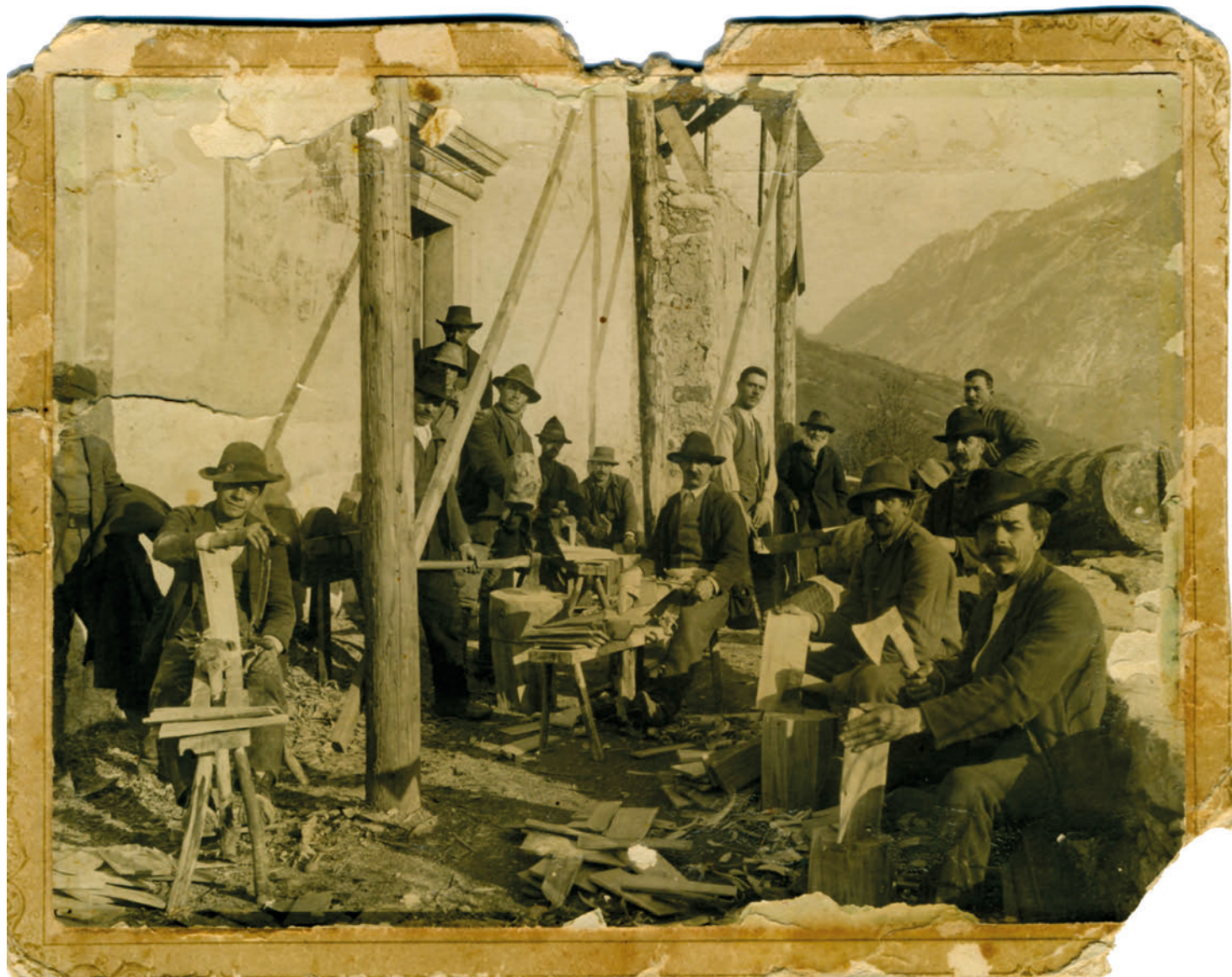
1921. Ricostruzione del tetto a scandole della Chiesetta di San Valentino.
