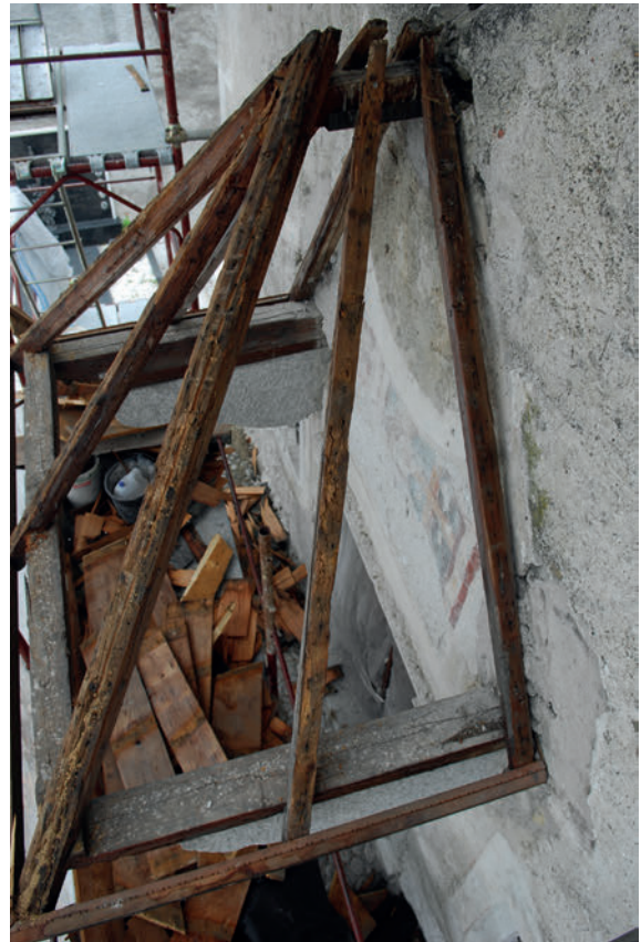
Il tettuccio piramidale durante lo smontaggio.
