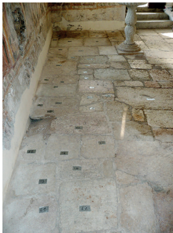
Il particolare della pavimentazione seicentesca in lastre di calcare con i riferimenti della mappatura per la temporanea rimozione.
