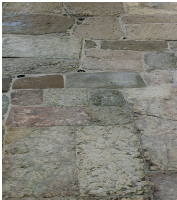
Un particolare del pavimento seicentesco in lastre di pietra calcarea.
