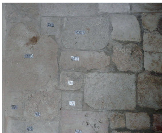
Un particolare della tessitura lapidea della pavimentazione con le fughe in malta cementizia, rimosse poi dal restauro.
