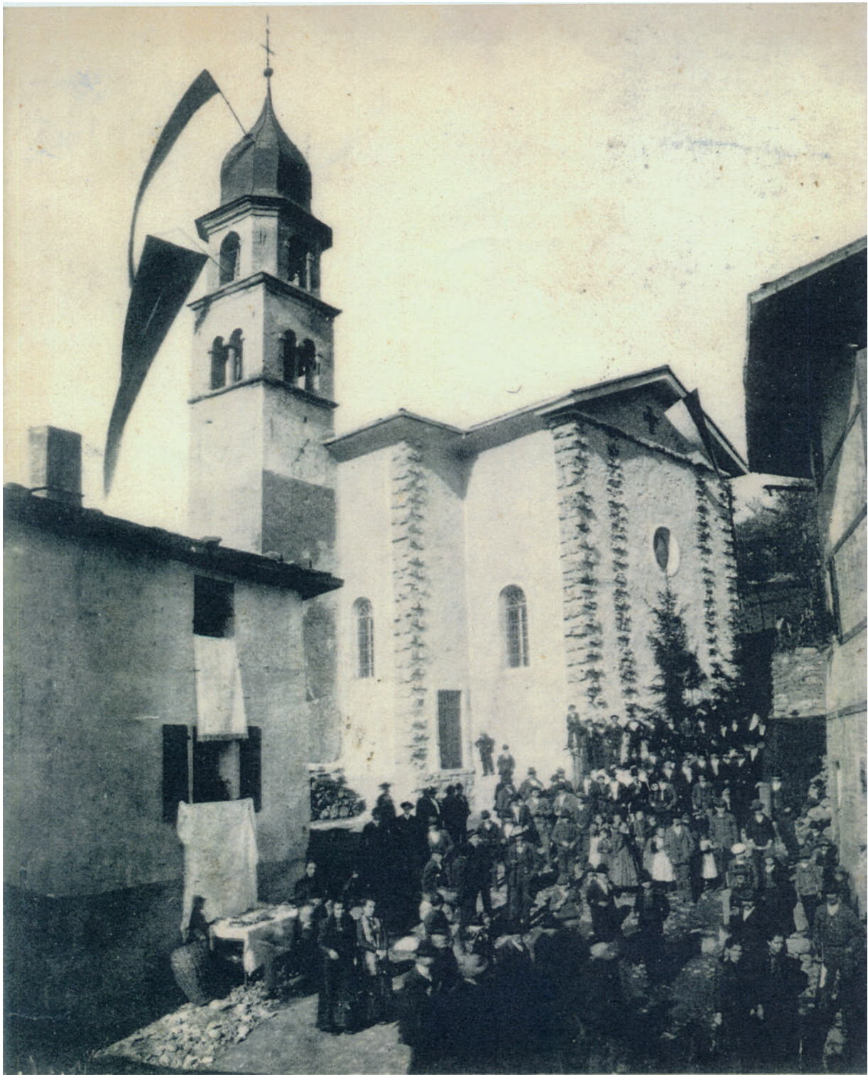
Una rara immagine della nuova chiesa dell'Assunta non ancora terminata, databile tra il 1905 e il 1907. Notare le incernierature di pietre sporgenti sugli spigoli e sulla facciata fatte per far aggrappare alla muratura le lesene decorative in malta e stucco. Il campanile è quello della vecchia chiesa della precedente foto. Sul timpano della chiesa e sul campanile sventolano dei vessilli bianco e rossi (?) dell'Austria (?). Da questo e altri particolari come la folla presente, le coperte sulle finestre, la bancarella in primo piano a sinistra e la concitazione generale si deduce che dovrebbe trattarsi di una giornata di festa per un avvenimento importante che potrebbe essere la Benedizione della nuova chiesa fatta dal curato don Francesco Pioner la domenica del 29 ottobre 1905. Foto Francesco Cemelani.
