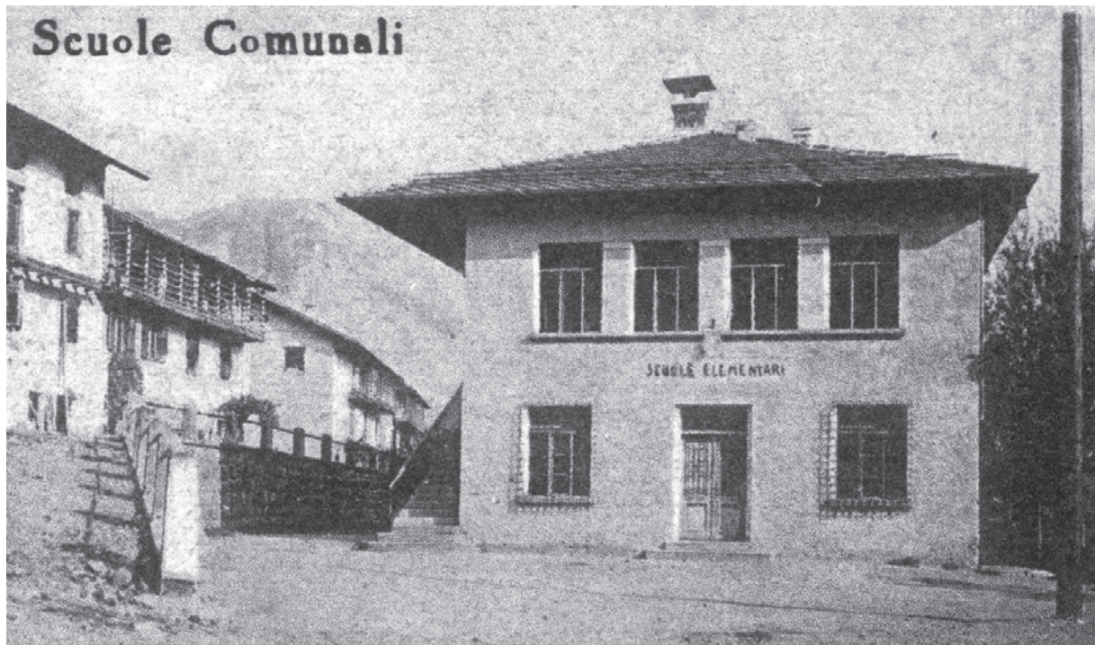
L'edificio del Municipio e delle Scuole Elementari prima dell'ampliamento (1940-1950 ca). Foto Trintinaglia.
