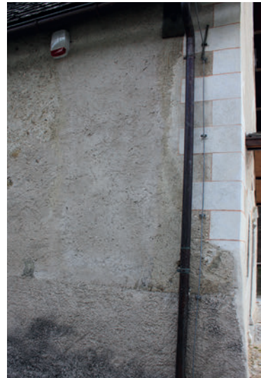
Il foro tamponato della porta della demolita cantoria.
