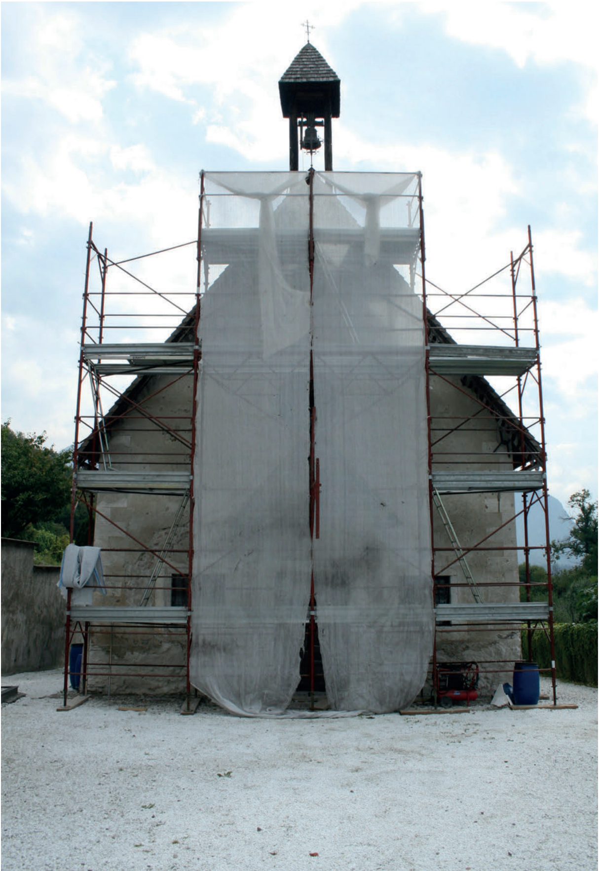
La facciata nel corso dei lavori di restauro, 2008.
