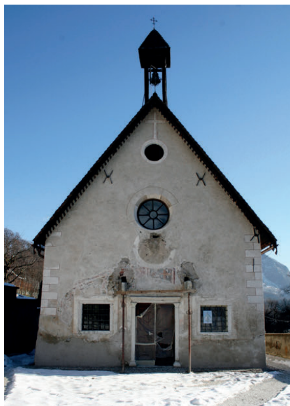
La facciata della chiesa durante gli ultimi lavori di restauro (foto 12-2008). Notare l'avvenuta rimozione del tettuccio settecentesco che ha messo maggiormente in luce il piccolo rosone seicentesco tamponato nel 1715. Nella foto sono ancora provvisoriamente in situ i due mensoloni in granito che reggevano il tettuccio.
