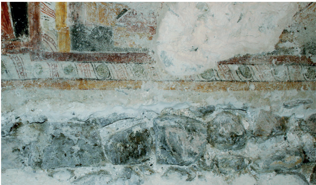
Un particolare, in corso di lavorazione, della parete sottostante agli affreschi.
