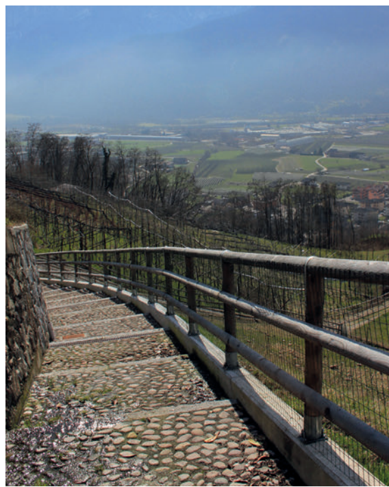
Un particolare del tratto riattato delle scalette nei pressi di Spera.
