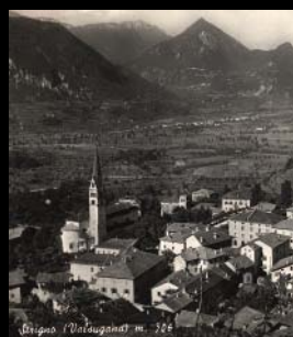
Vista da est, 1953 ed. Trintinaglia
