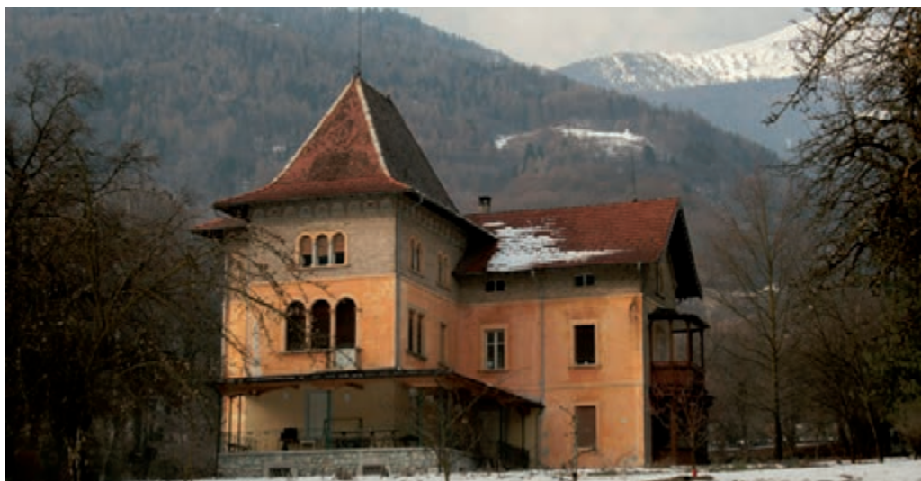
Villa Gordon vista dal parco, fine '800- inizio '900.
