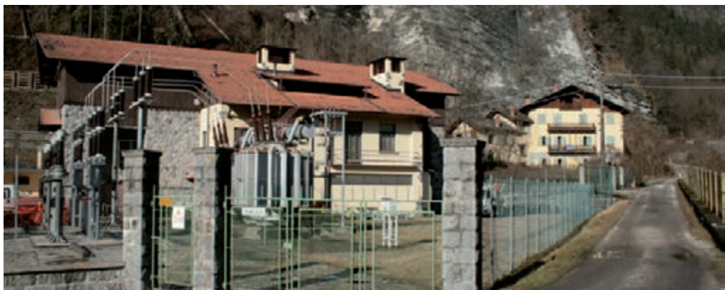
Carzano, Centrale elettrica , 1938.
