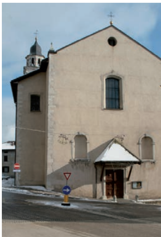
Parrocchiale di Telve, facciata .
