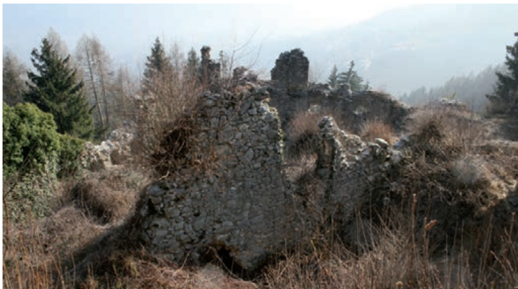
Castellalto, il Palazzo nuovo e gli edifici a sud-ovest come si presentavano nel 2008.
