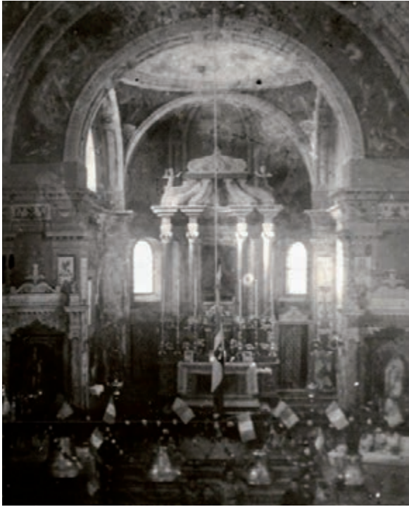
La chiesa negli anni Venti. Notare la decorazione neorinascimentale di Ubaldo Tasselli (per gentile concessione di Natalino Stroppa).
