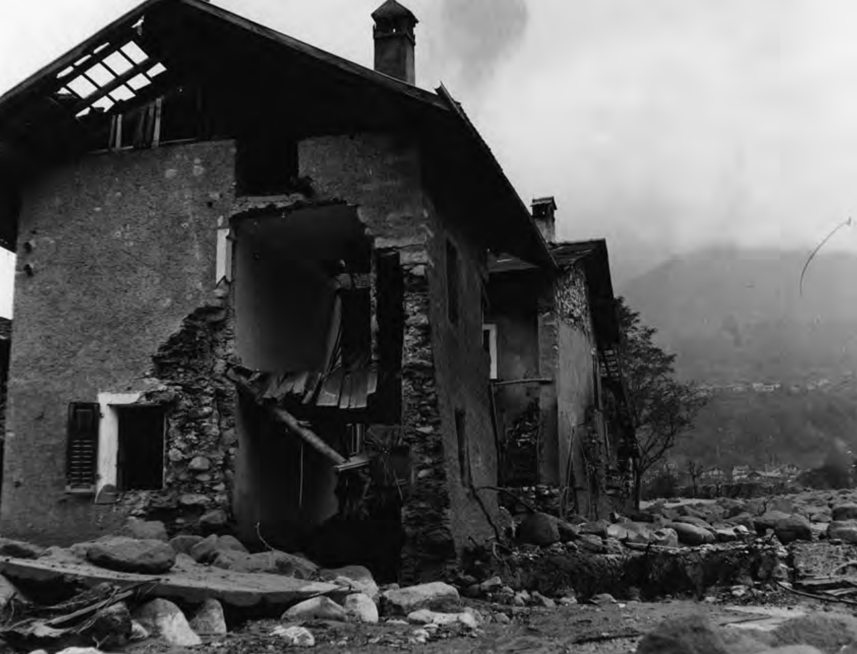
Villa Agnedo, località Villa, abitazioni danneggiate dal torrente Chieppena foto Nereo Tomaselli, archivio dell'autore, Strigno
