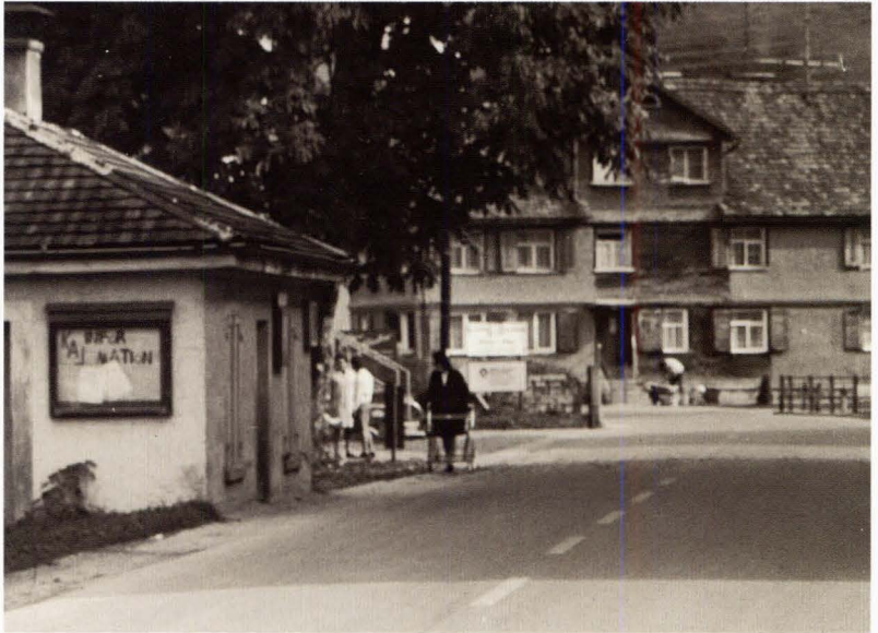
Per la 'casa al 30' era stata allestita una lavanderia (nella fotografia a sinistra), nella quale le 12 famiglie potevano lavare secondo un orario stabilito dalla fabbrica.
