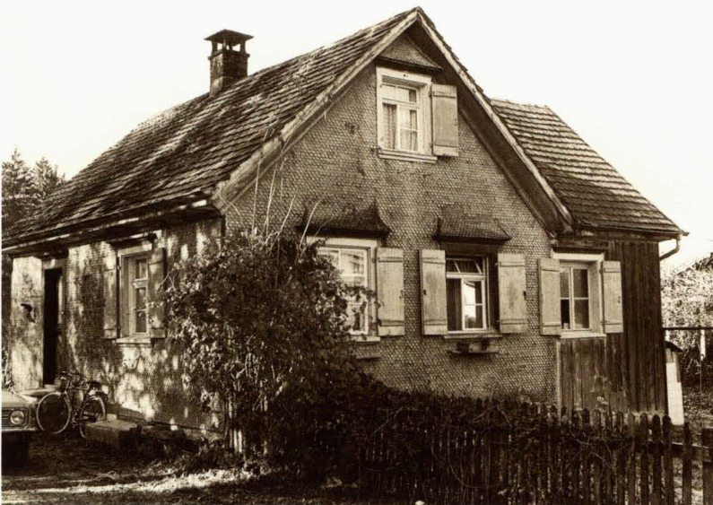
Tra gli oggetti alienati nel 1871 vi erano anche il ponte costruito dal cotonificio sulla Bregenzerach e la piccola dogana, che oggi non esistono più.
