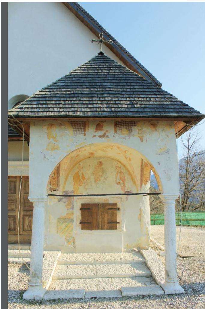
Il Protiro cinquecentesco dopo il restauro.
