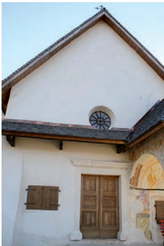
Particolare della facciata dopo il restauro.
