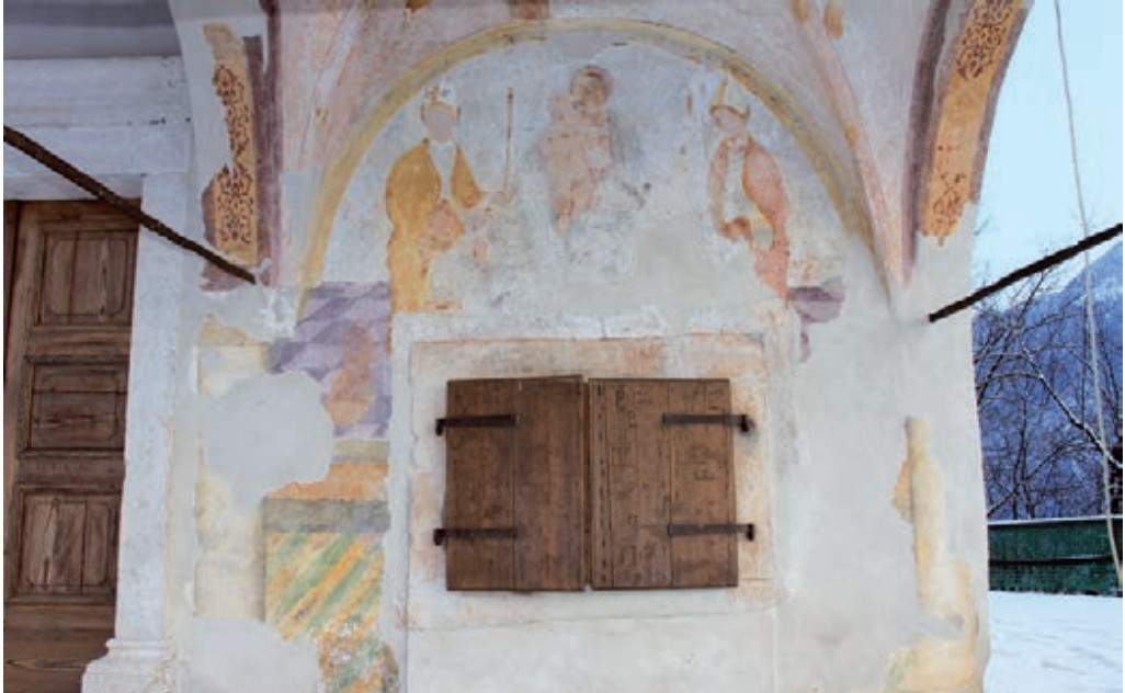
Sopra, la parete di fondo del protiro con la Sacra Conversazione mutilata dall'apertura della finestrella. La rimozione dei barbacani cinquecenteschi ha rimesso in luce sulla parete di fondo la partitura architettonica che dilatando lo spazio creava un effetto di trompe-l'oeil . Prima metà del XVI secolo.
