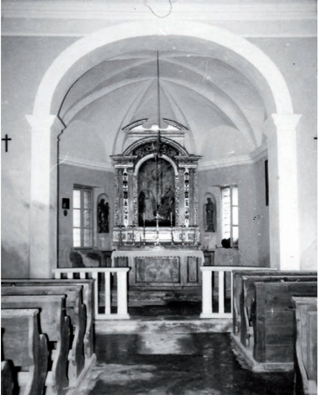
L'interno della chiesa in una foto del 1968. Foto di Giuliano Fabbro. Notare la presenza della balaustra, proveniente dalla Chiesa-Baracca, che divideva la zona presbiteriale dall'aula, rimossa in seguito, l'antependio davanti all'ancona lignea seicentesca e la presenza nelle nicchie ai lati dell'altare delle due statue lignee di Giacomo Vincenzo Mussner.
