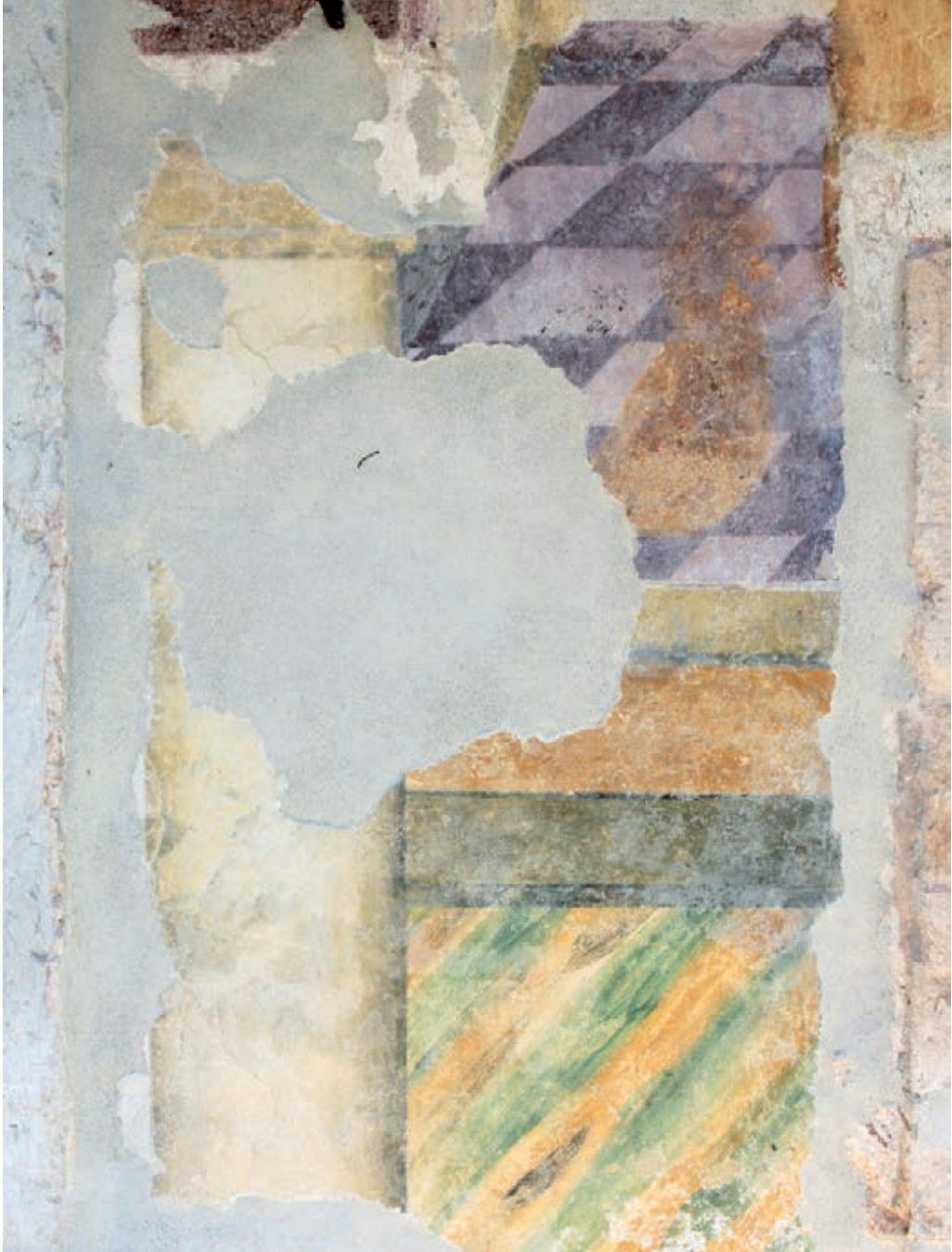
Particolare della complessa decorazione architettonica che completava la parete del protiro, venuta alla luce nell'ultimo restauro.
