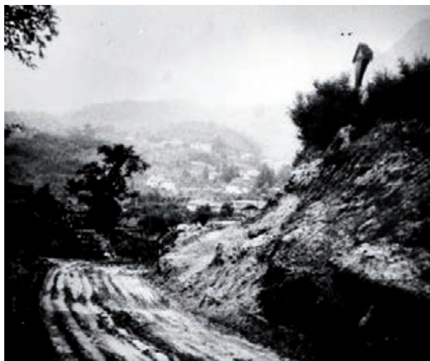
Sotto, il Crocifisso nella sua posizione originale, durante i lavori di allargamento e sistemazione della strada proveniente da Strigno. Anni 1950-55 ca. Foto Archivio Comunale di Ivano Fracena.
