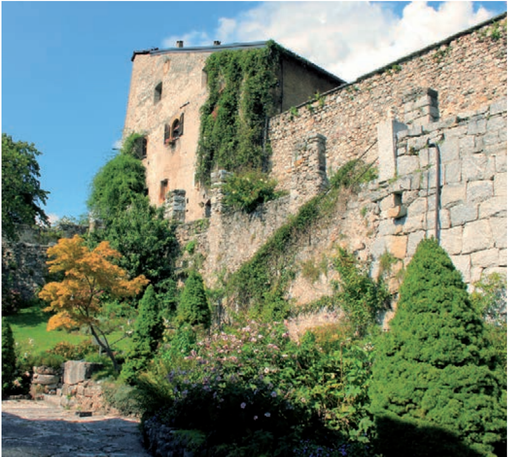
Il Palazzo di là visto dal cortile dove si nota il carattere eminentemente militare e difensivo della costruzione. Sul lato nord lo spessore della muraglia arriva a quasi tre metri.
