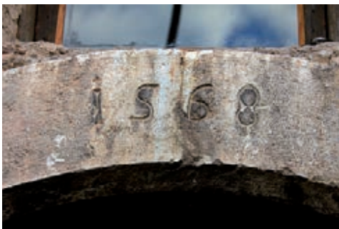
Particolare della data 1568 incisa sull'arco del portale.
