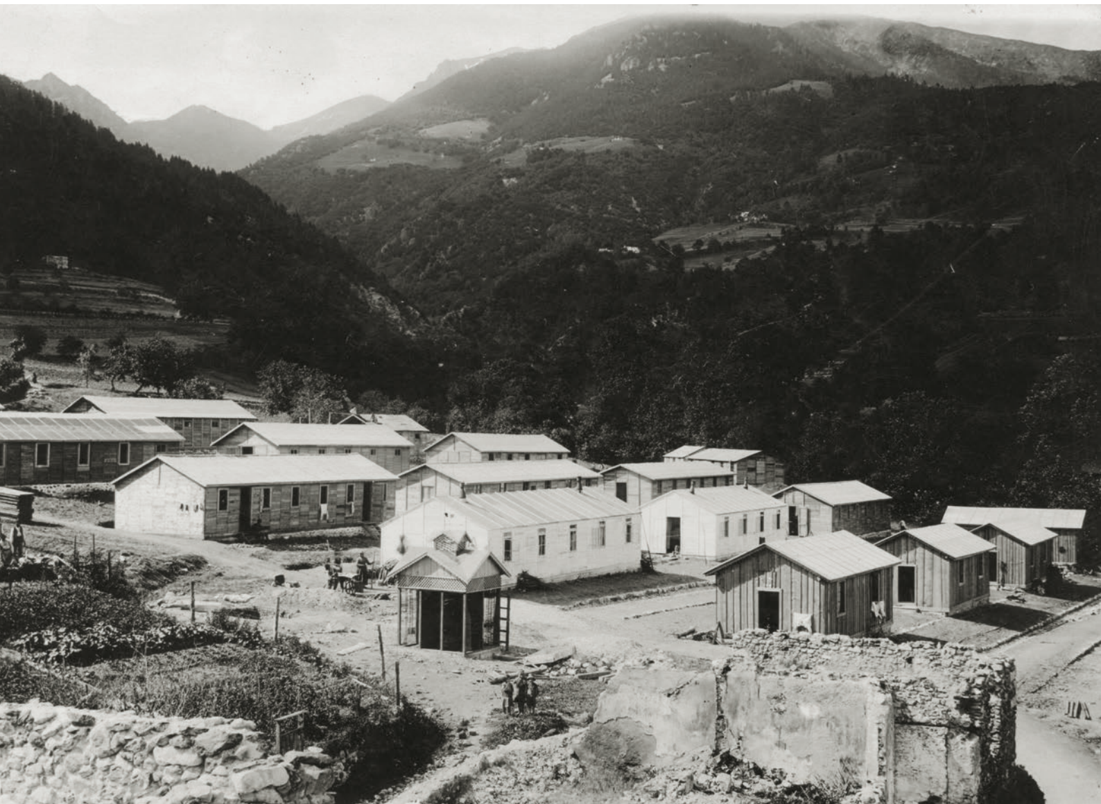
Aprile 1919. Le baracche modulari sono pronte ad accogliere i profughi da poco ritornati al distrutto paese natìo. (Foto L. Giroto)
