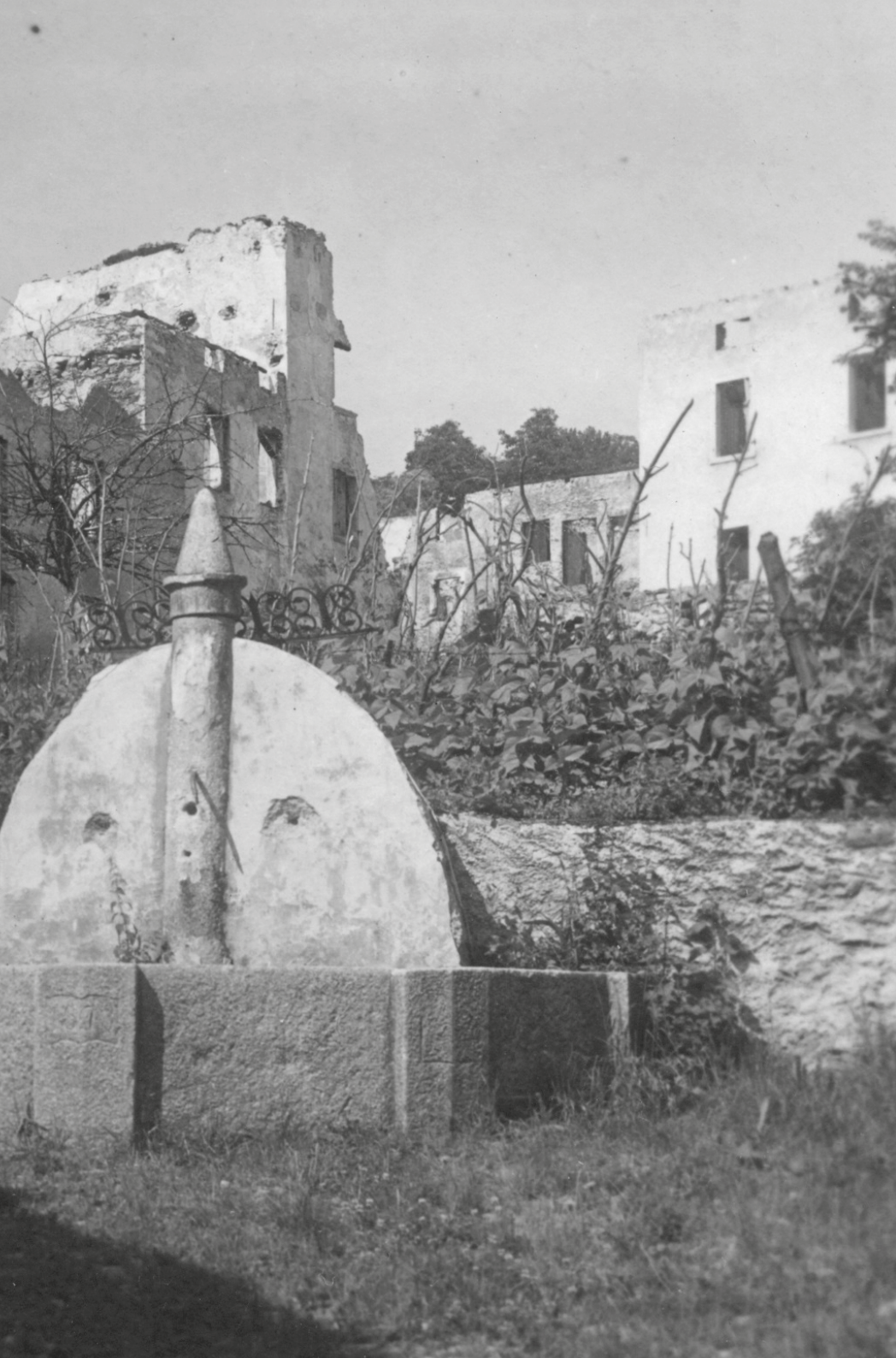
Torcegno, autunno 1916. L'entrata orientale del villaggio, con le distruzioni causate dagli opposti cannoneggiamenti. (Foto L. Girotto)
