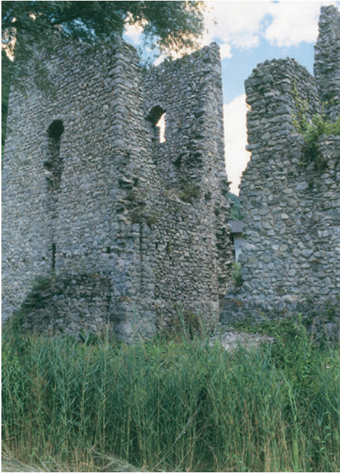
Fig. 19: Torre Quadra, angolo Sud-Est del corpo A, ripreso da Sud.
